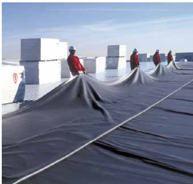
Aplicación en una cubierta de grandes dimensiones
